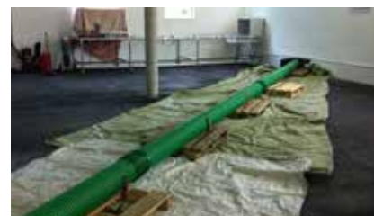
Zkouška čištění potrubí
