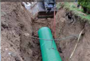
Výstavba lesních cest PP-MEGA SN12
