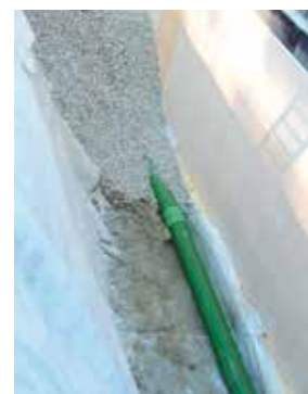
Pokládka PP-MEGA-Drain SN12
