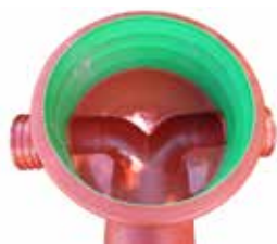
Dno šachty s kynetou
