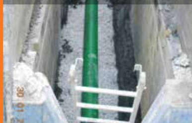
Rekonstrukce skládky PP-MEGA SN12
