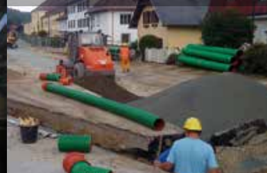
Odvodnění silnic PP-MEGA SN12
