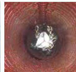
Vodní řetězová fréza v potrubí
