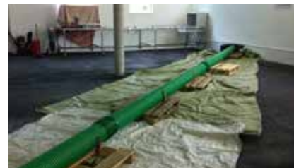
Zkouška čištění potrubí
