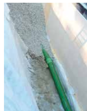
Pokládka PP-MEGA-Drain SN12
