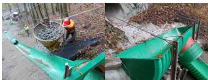
Půlené potrubí jako záchytné nádrže pro povrchové vody
