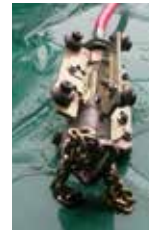
Vodní řetězová fréza v potrubí
