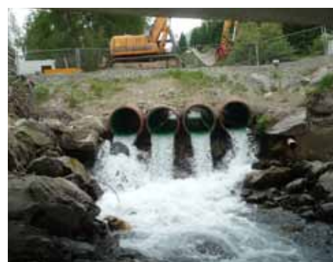
Propustky PP-MEGA SN8 potrubí
