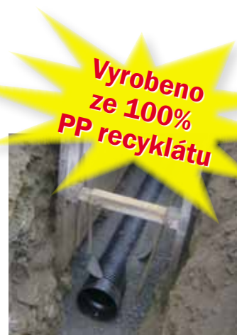
Výstavba silnice PP-WELL-Drenáž SN8
